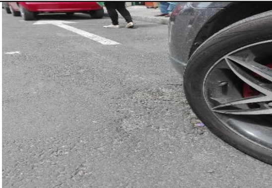
Falla carpeta (piel de cocodrilo incipiente) costado occidental
