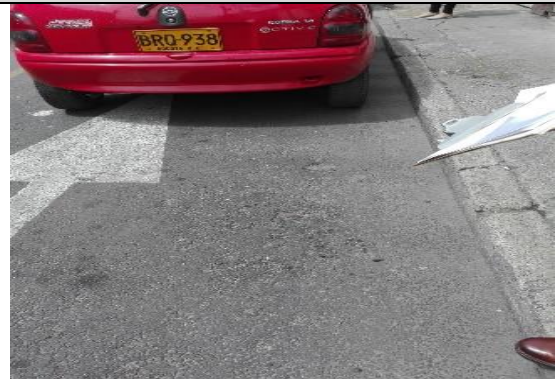
Falla carpeta (piel de cocodrilo incipiente) costado occidental
