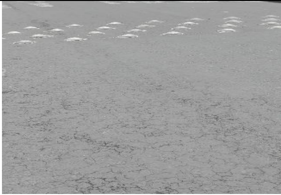
Falla carpeta (piel de cocodrilo incipiente) costado occidental
